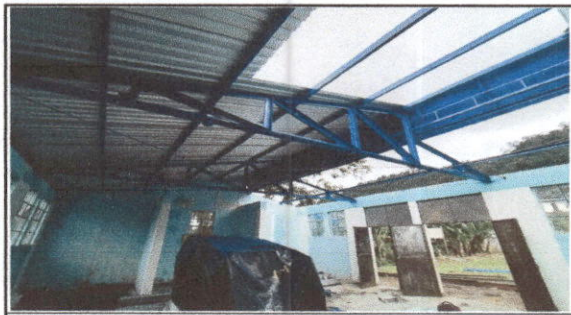
FOTO 6: Instalación de lámina troquelada aluzinc
