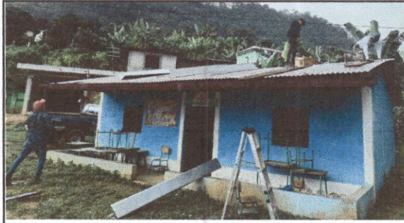
Foto 4: Sustitución de canal de metal
