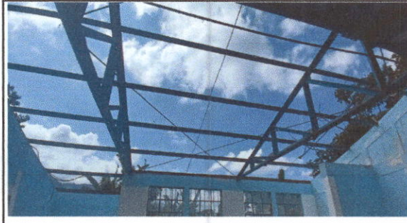
Foto 2: Mantenimiento a estructura de soporte de metal
