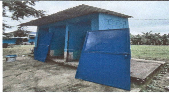
Foto 1: Mantenimiento a estructura (lijado, cambio de tubo , cepillado, sujeciones, aplicación de pintura) a puertas servicios sanitarios
