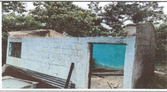
Foto 5: Sustitución de lámina, por lámina troquelada aluzinc calibre 26
